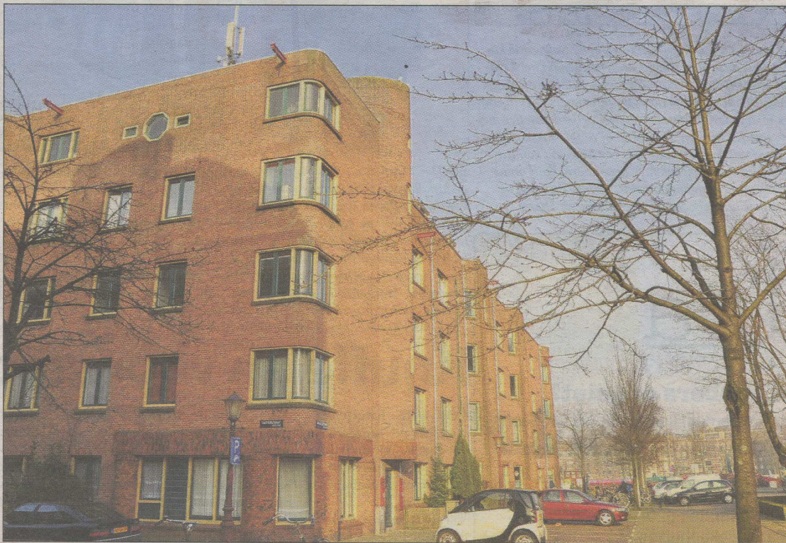
De zendmast op het woongebouw op de hoek van de Smaragdstraat en de Saffierstraat. (Foto: Sandra de Haan)
